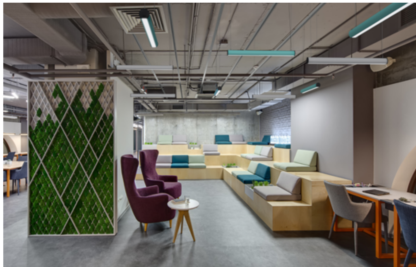
Espacios con instalaciones vistas (sin falso techo).
