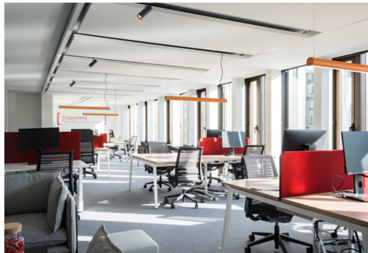
Espacios con instalaciones semi-ocultas (Paneles acústicos de gran formato).
