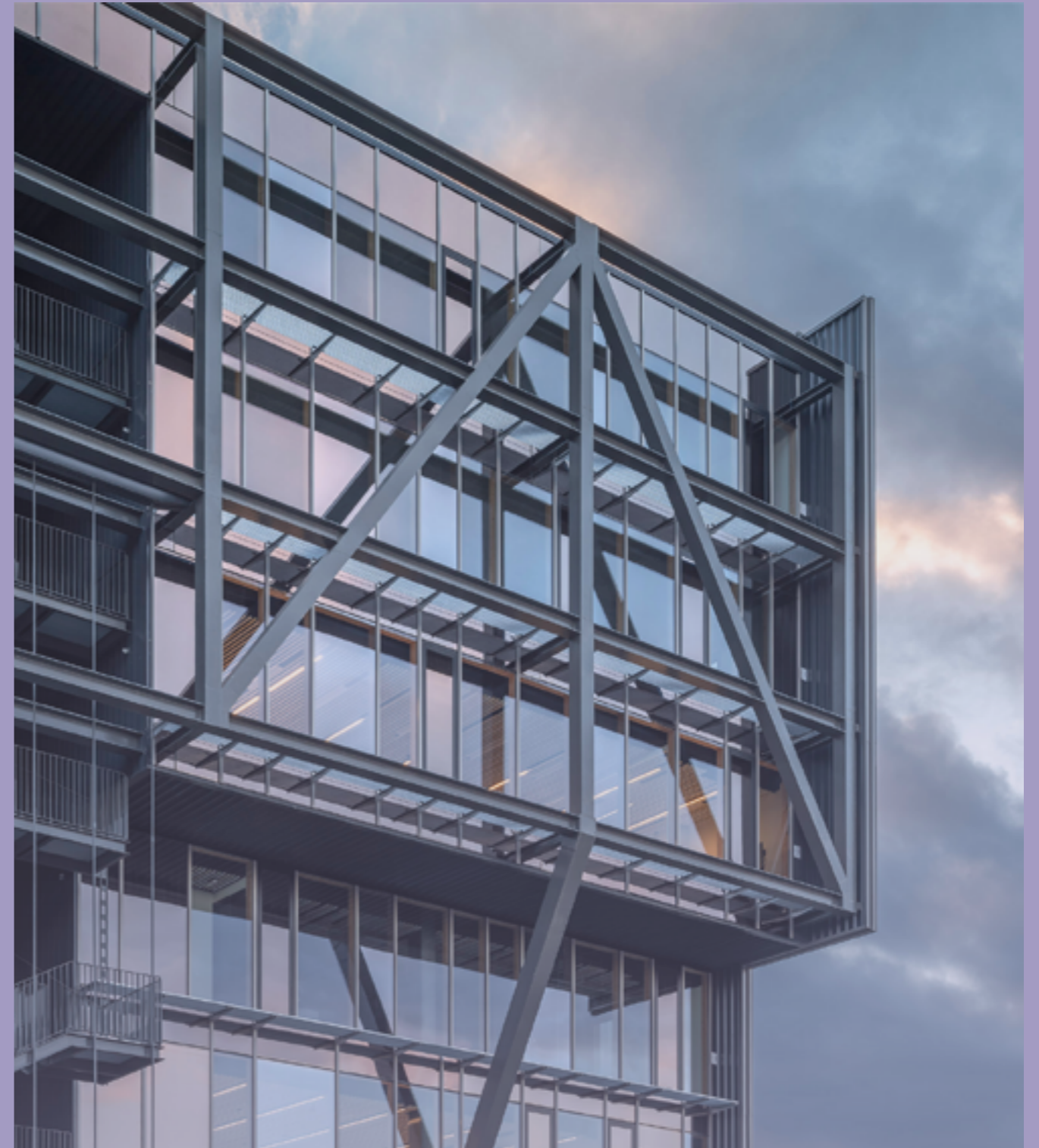
Edificio SLOW, Sant Cugat, España
